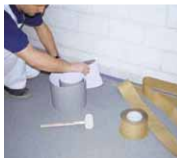
Переход каучукового покрытия noraplan® на стену
