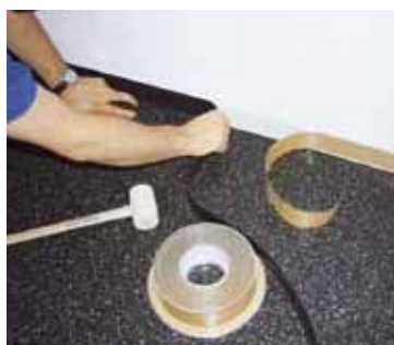
Укладка плинтусов nora®
